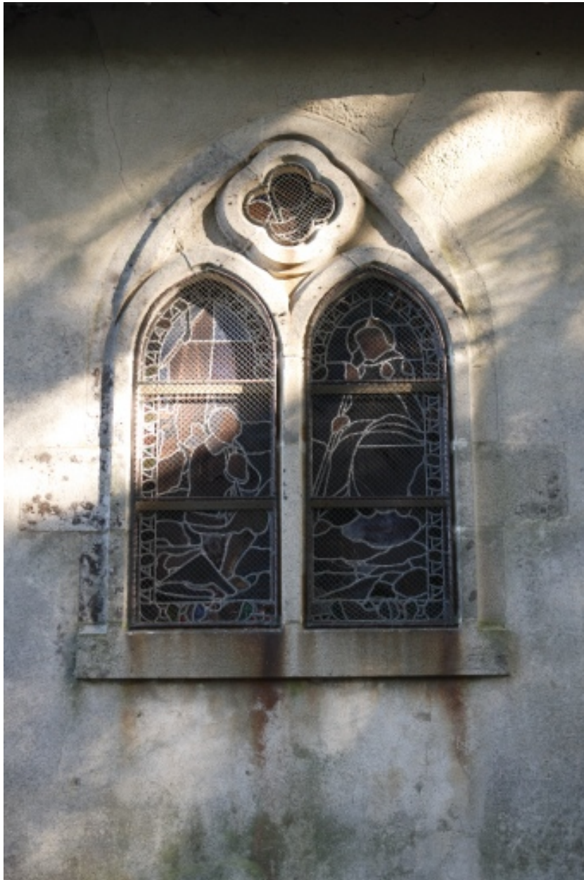
Détail de la baie géminée sud.
