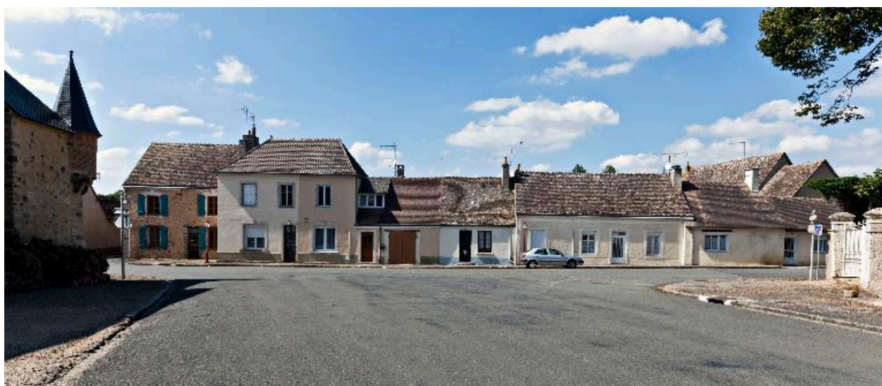
Vue d'ensemble du côté ouest de la place de l'église.
