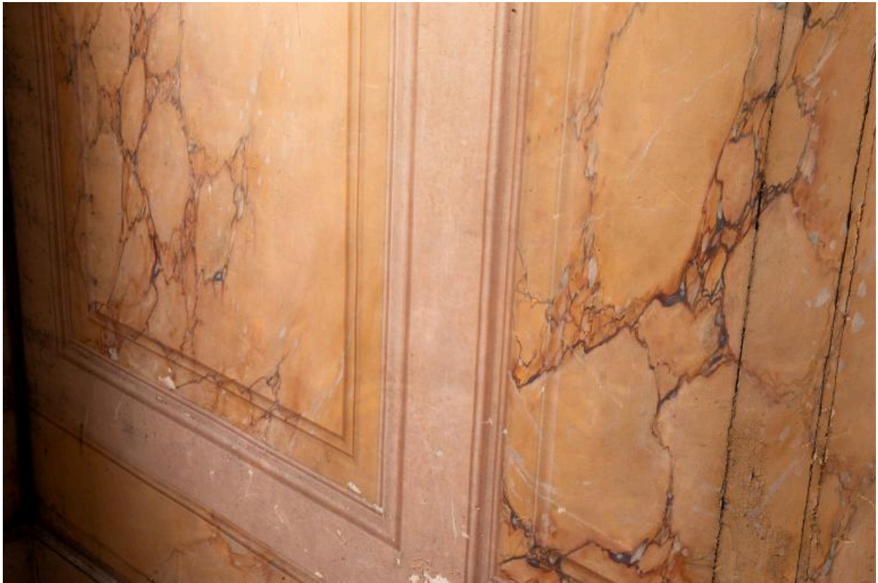
Un détail de la cage d'escalier, décor de faux-marbre peint.
