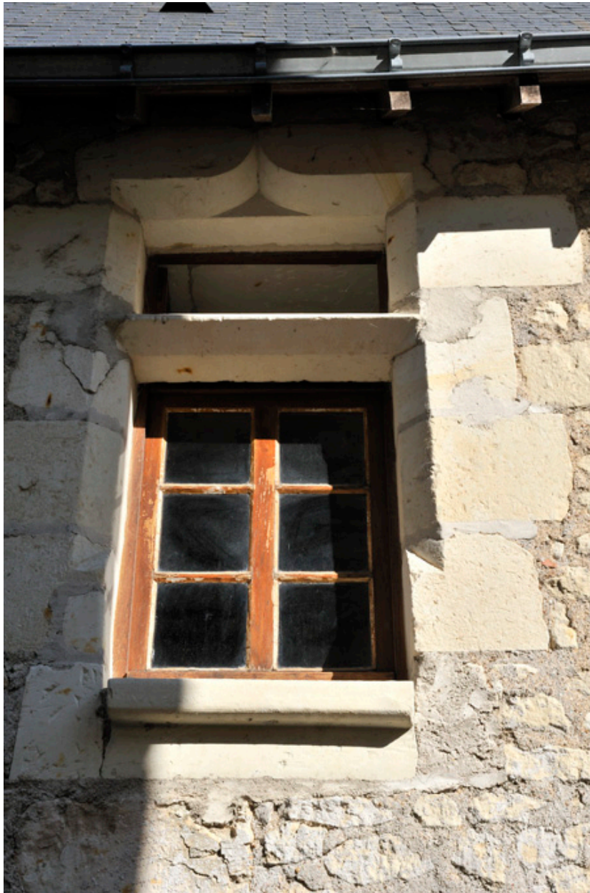
Façade ouest : détail de la demi-croisée, chanfreinée, avec accolade et congés (1).
