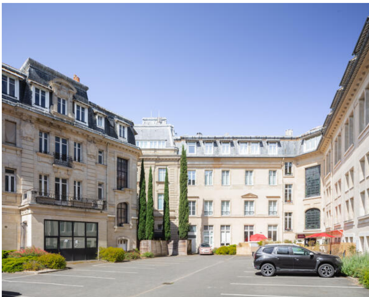
Vue de la cour intérieure des Mutuelles avec les façades arrières des bureaux et de la demeure patronale.
