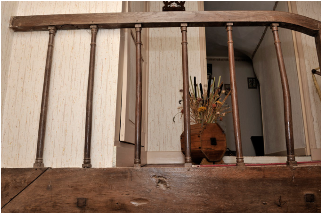
Escalier : rampe d'appui.
