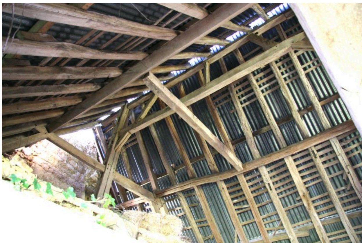
Charpente à pannes avec encoches et sous-faîtage.
