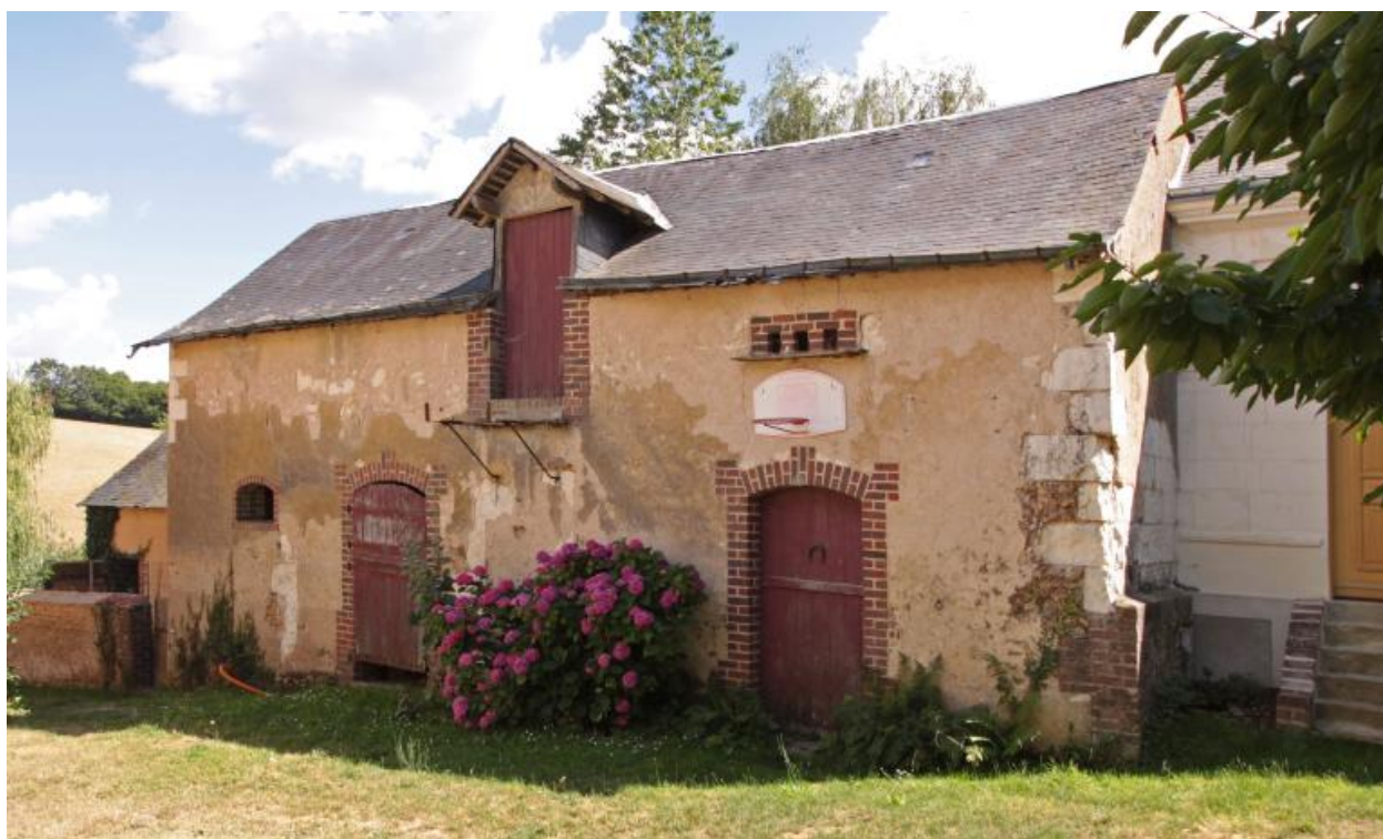
Bâtiment des étables, avec pigeonnier dans le comble.
