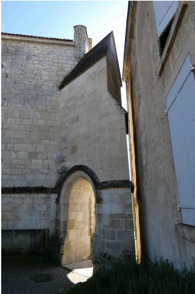
Le contrefort nord-ouest, frôlant le bâtiment voisin, vu depuis le nord.
