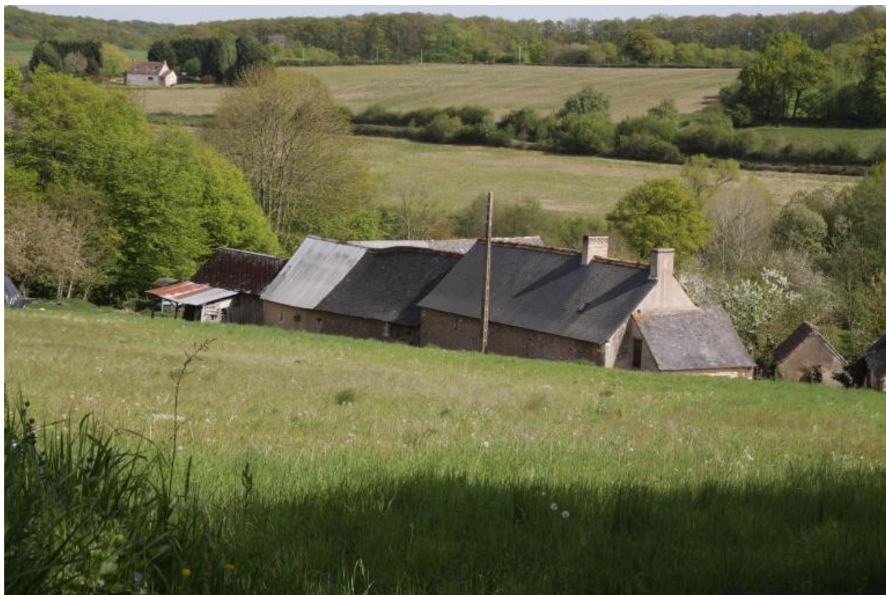
Vue d'ensemble prise depuis le nord-ouest.
