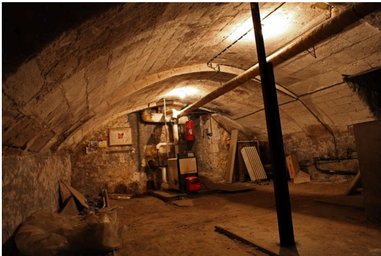
Cave voûtée au sous-sol : vue vers le nord.
