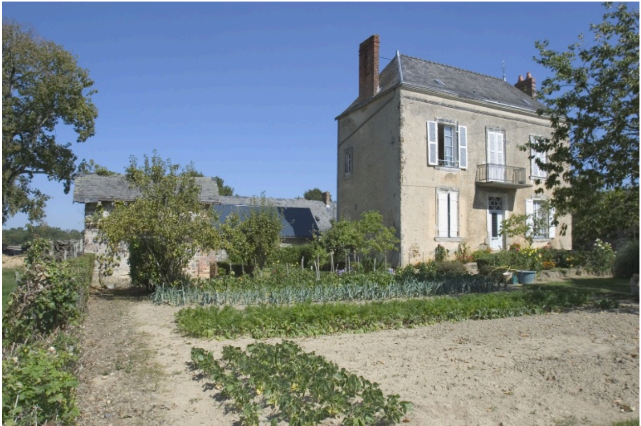
La maison de maître et le chenil (?) vus depuis le jardin au sud-ouest.
