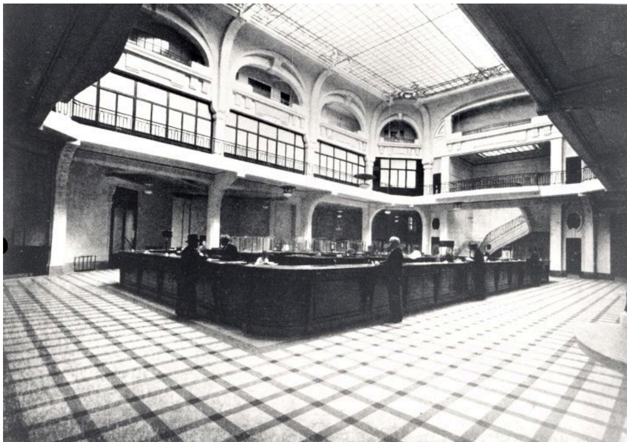
Le hall : élévations postérieure et latérale droite, fotogr., de H. Jamard, [v. 1920].
