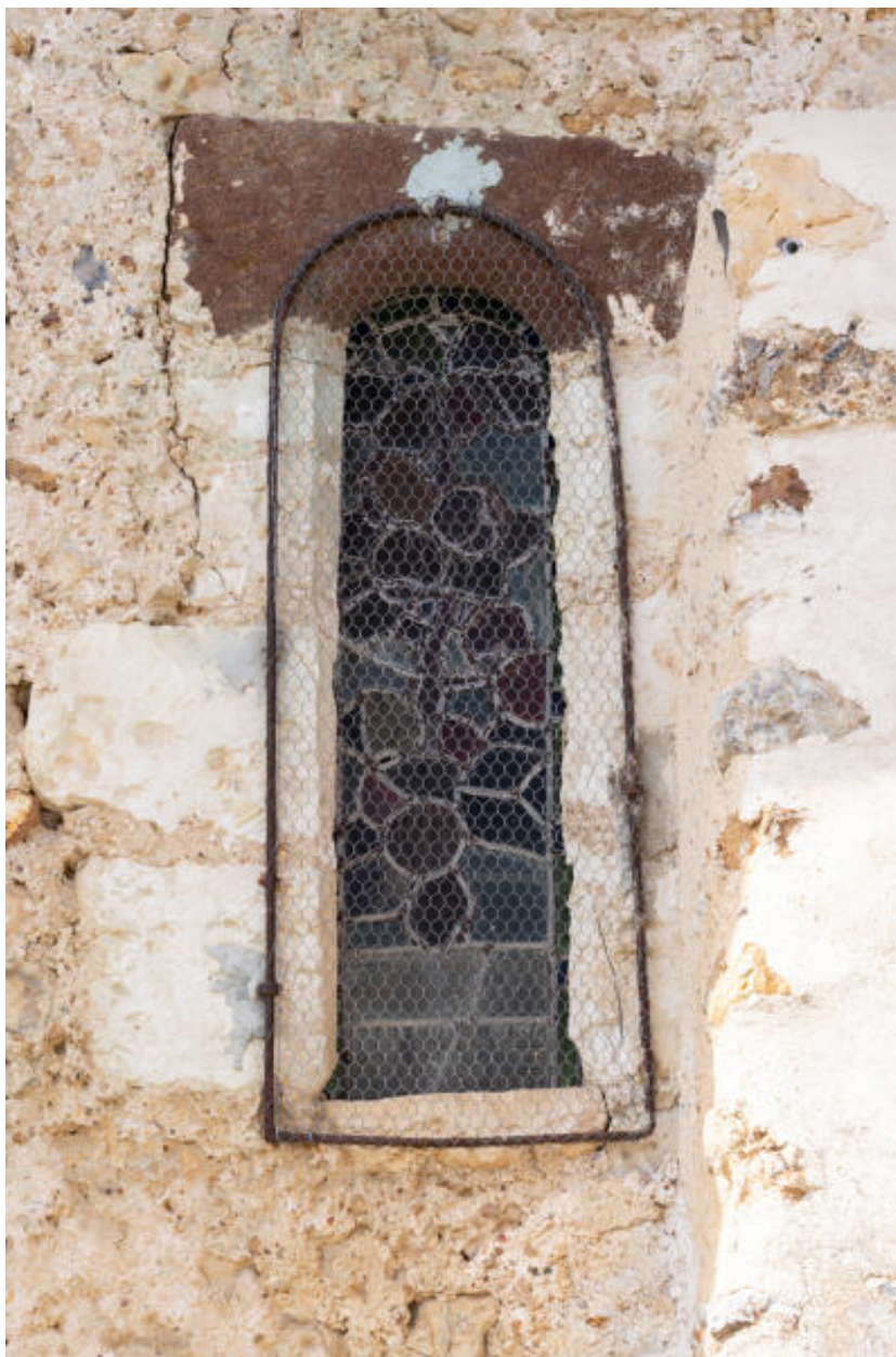
Fenêtre de la nef, côté sud-est.
