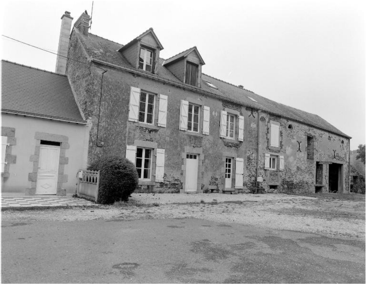
Le bâtiment de dépendance. Façade principale, sur la cour.
