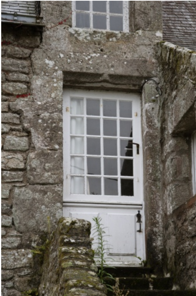
Détail de l'ancienne croisée du 1er étage transformée en porte.
