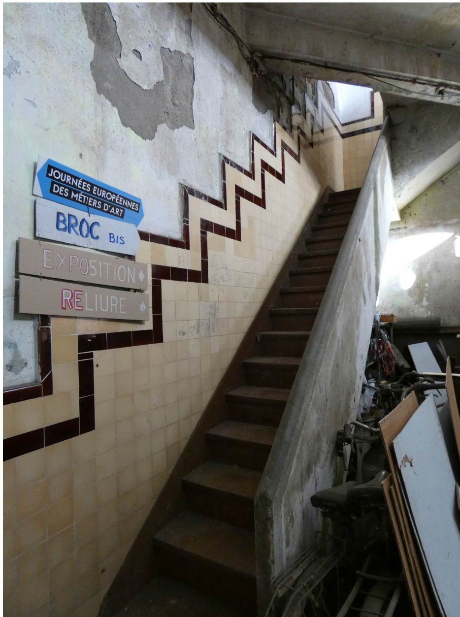
Escalier entre le rez-de-chaussée et le premier étage du bâtiment d'atomisation.
