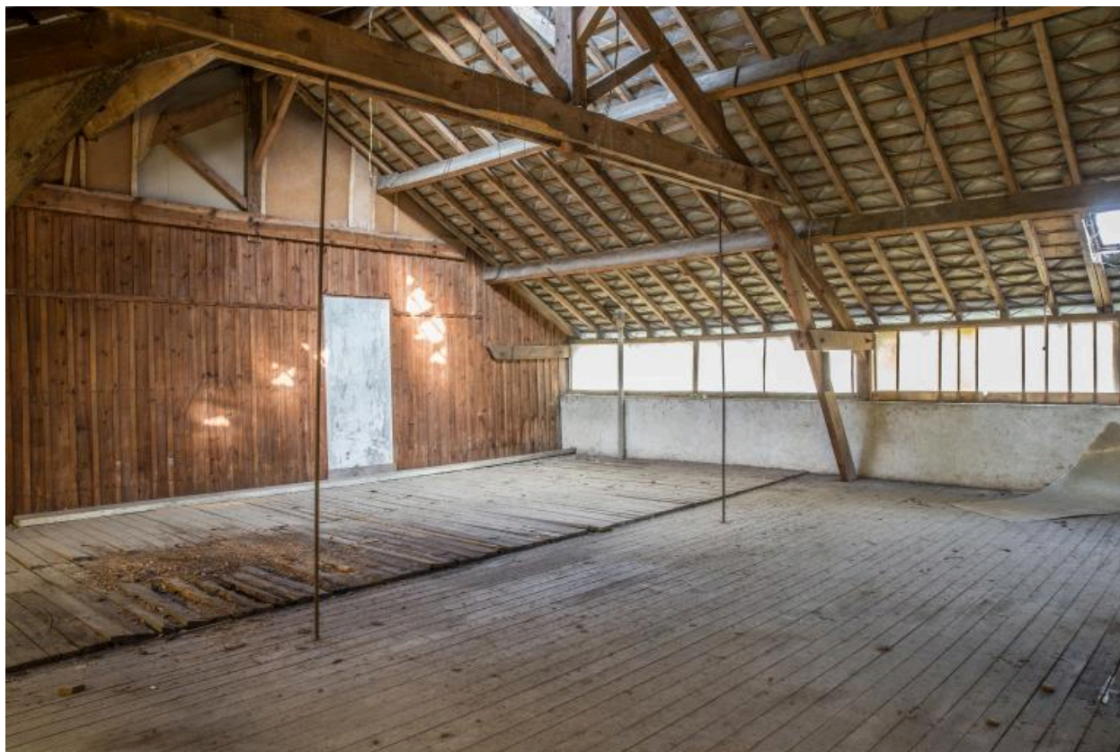
Le comble à surcroît de l'usine.
