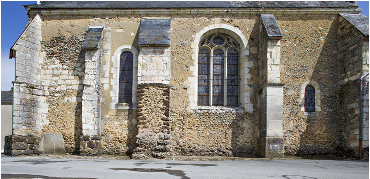
Le mur sud de la nef.
