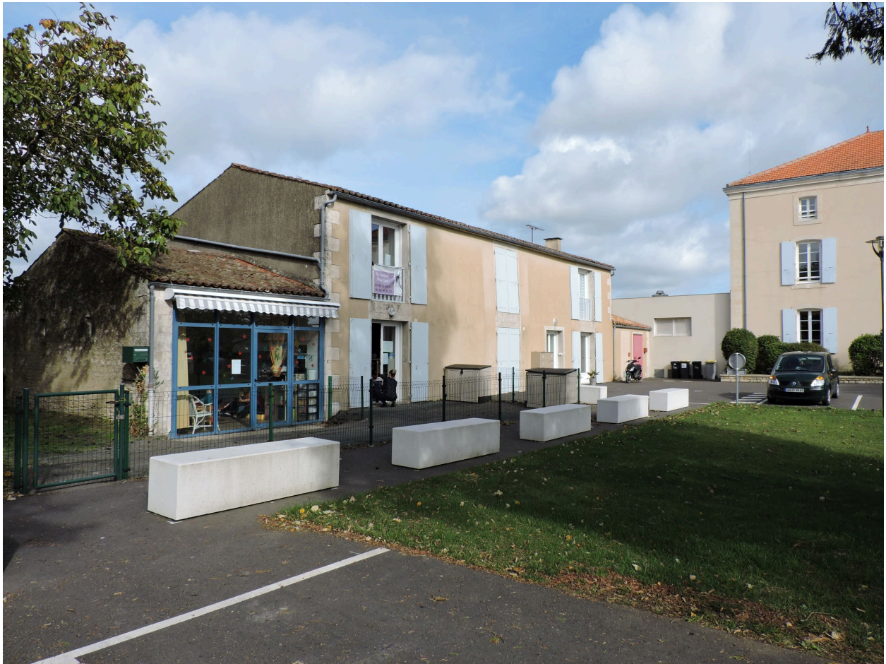
L'aile nord de communs, occupé aujourd'hui par la crèche, vue depuis le sud-ouest.
