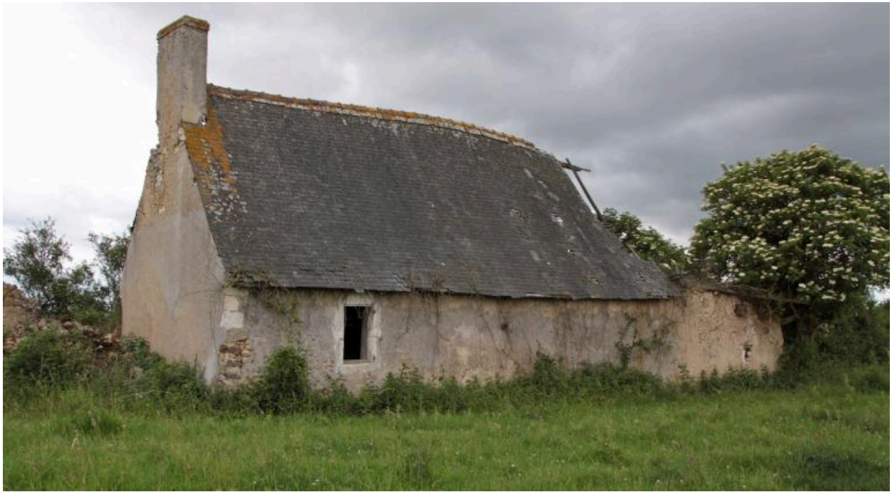
Vue de volume avec façade postérieure de la maison.
