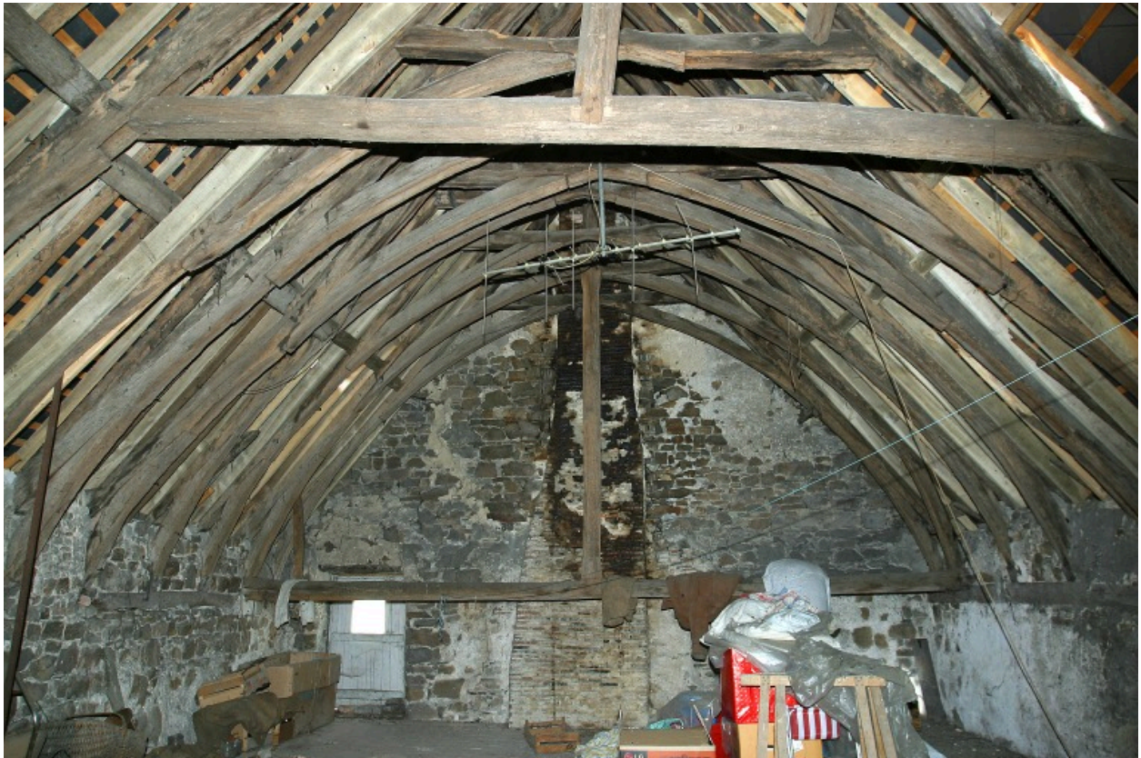
Comble : la partie nord de la charpente vue depuis le sud.
