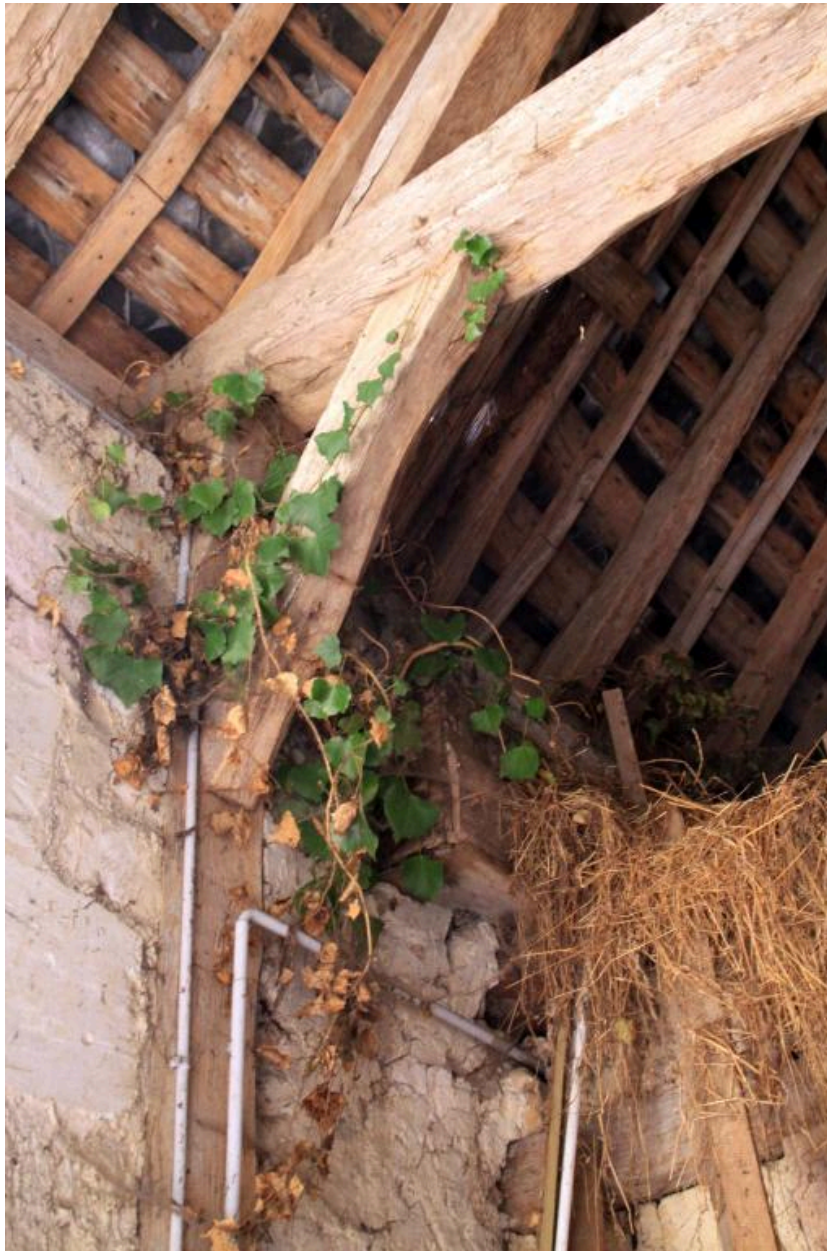
Grange : détail d'un poteau de bois.
