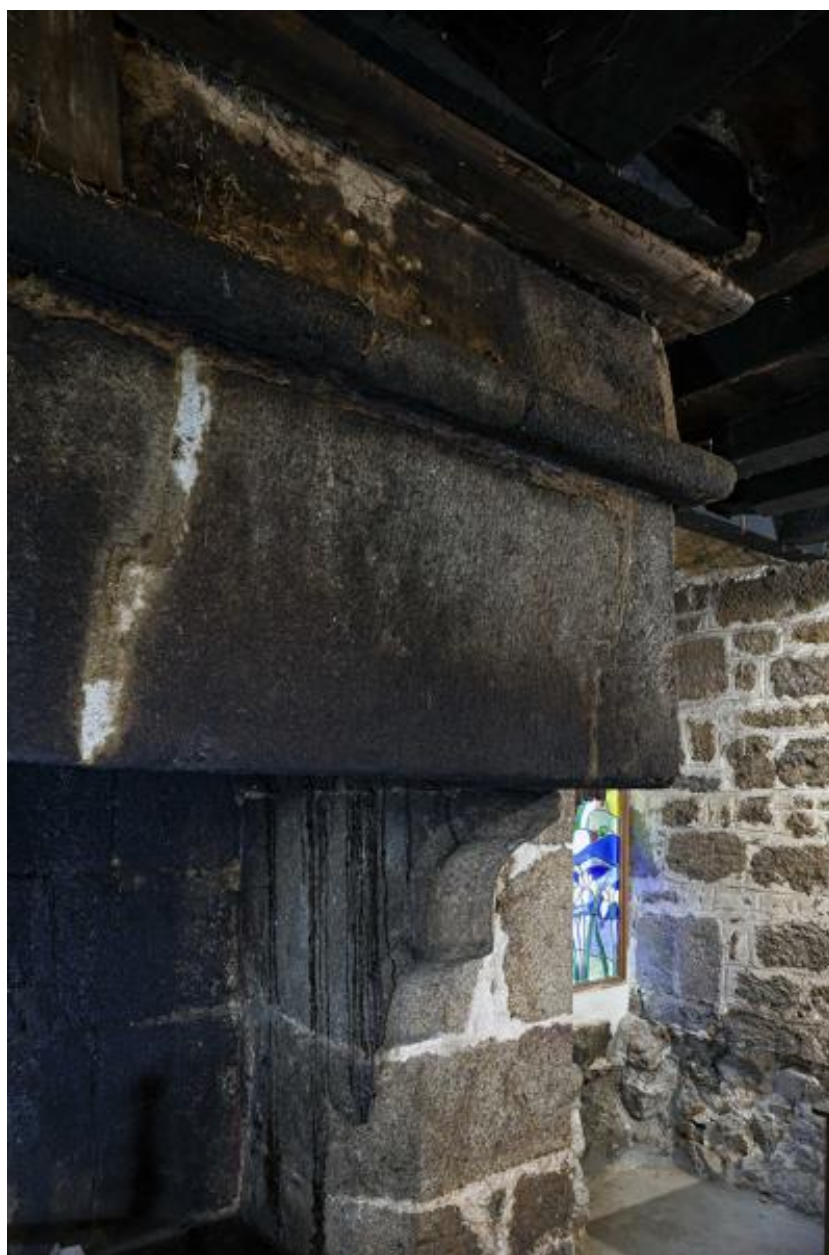
Corbeau droit de la cheminée.
