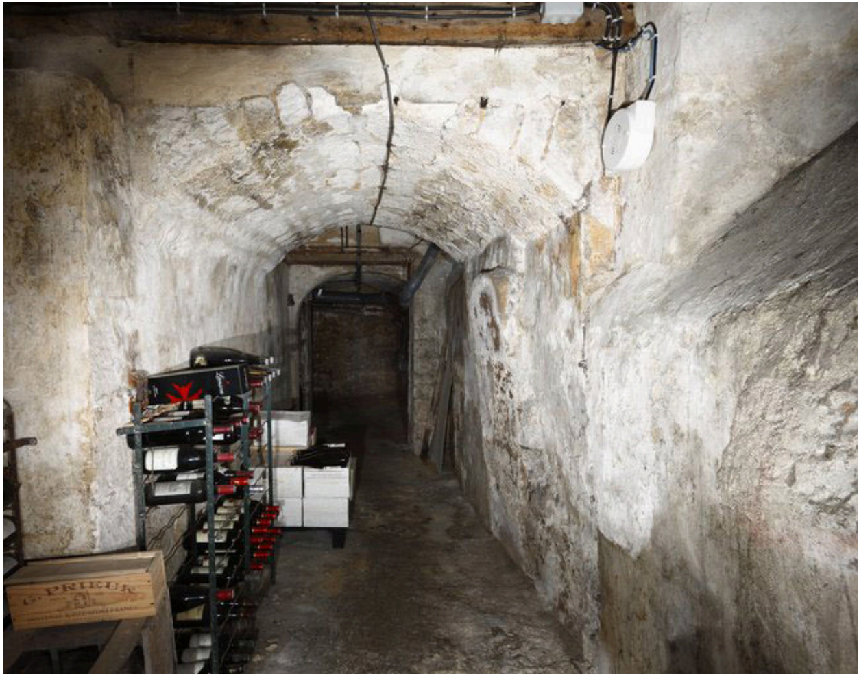
Vue de la cave prise de l'est, en direction de l'escalier d'accès.
