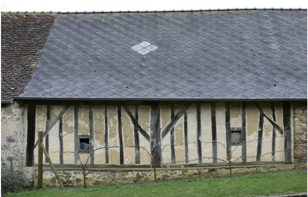
L'étable-grange, élévation postérieure : la partie centrale.
