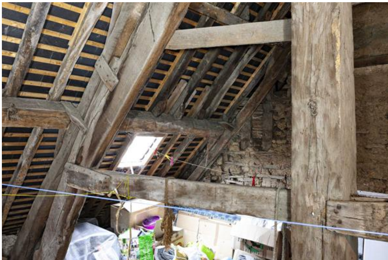
Charpente du corps de logis principal, côté 17 Grande-Rue, détail.
