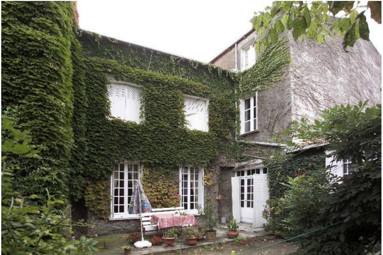
Vue de la façade postérieure.
