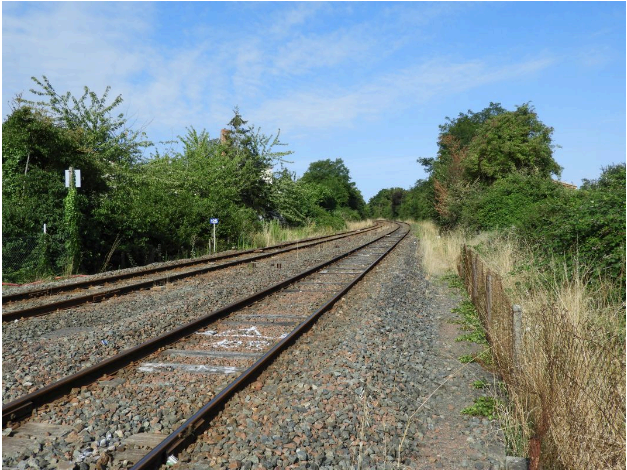
La voie ferrée en direction de l'ouest, au sud du bourg et à l'ouest de l'ancienne gare.
