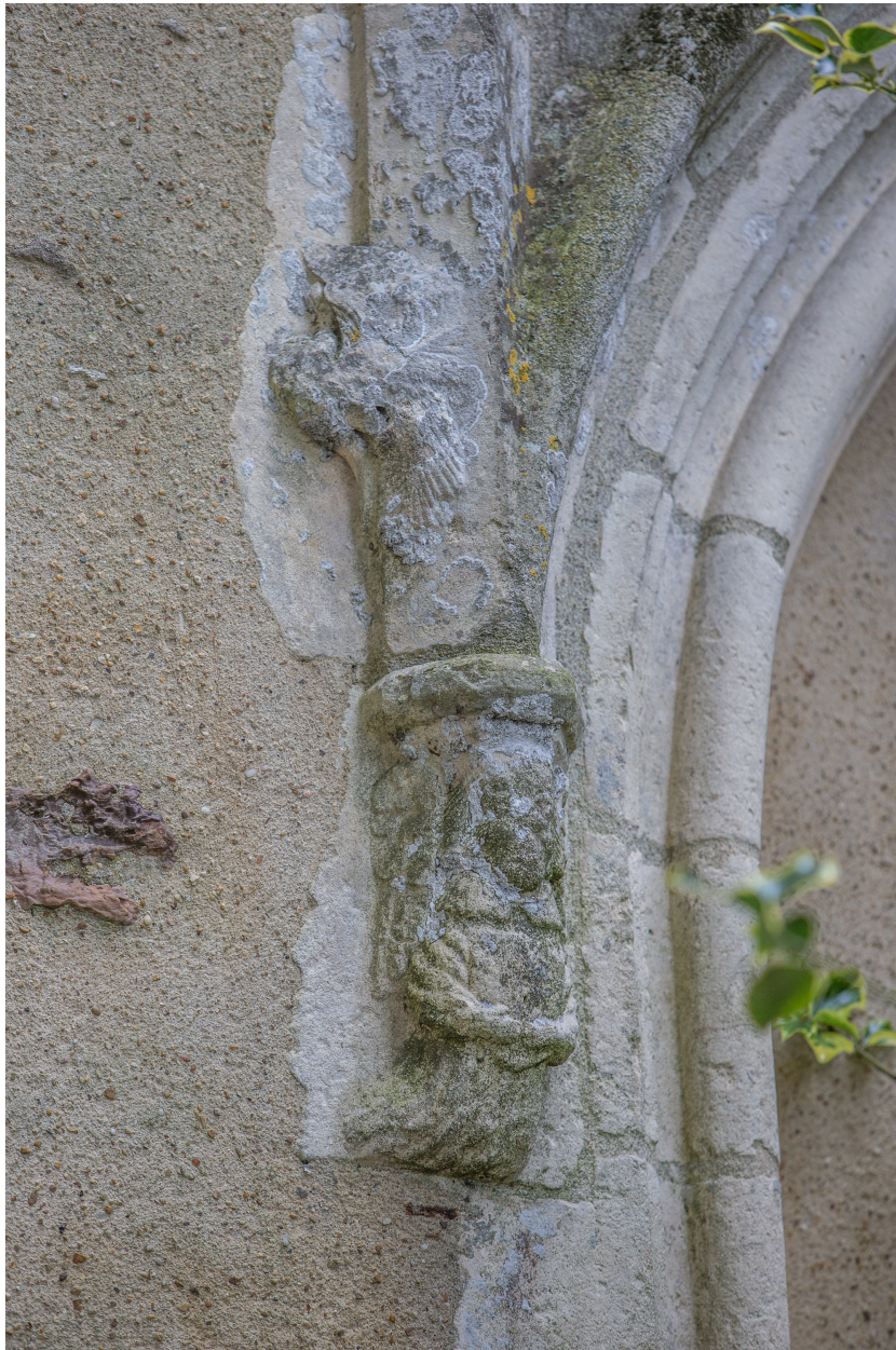
L'ancienne porte murée au pied du clocher, détail.
