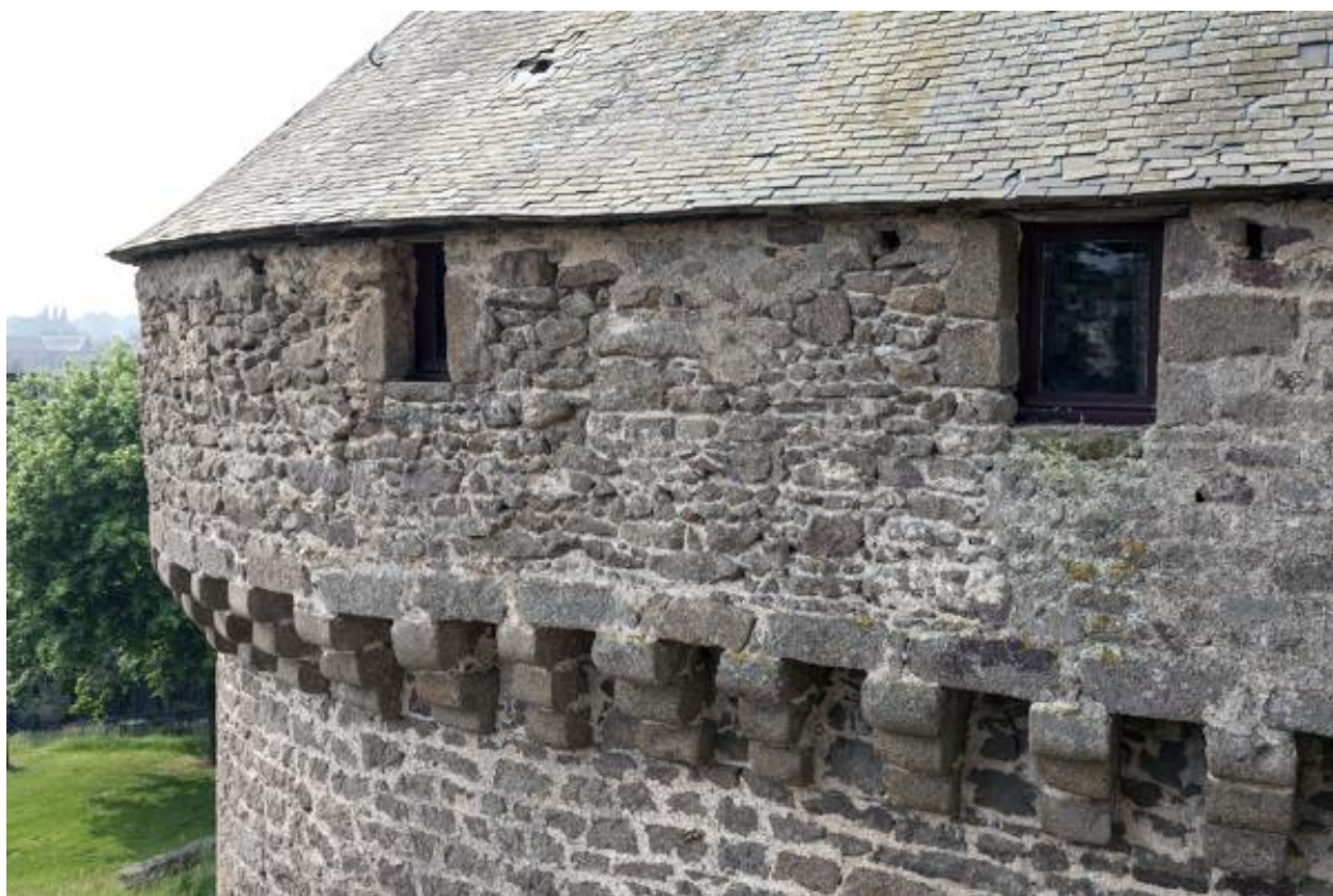
Chemin de ronde de la tour 5.
