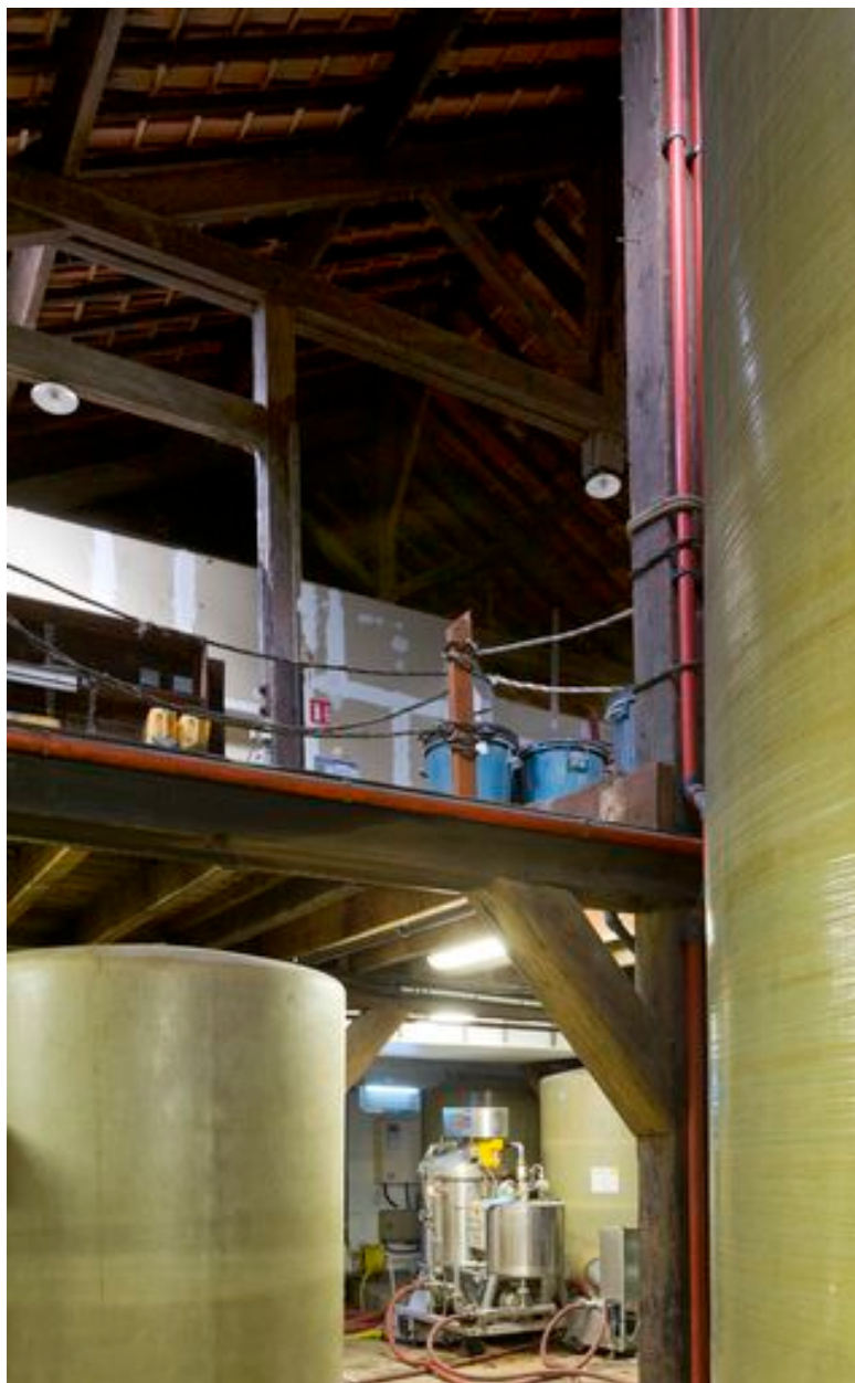
24 rue des Chantiers Crucy : charpente en bois.
