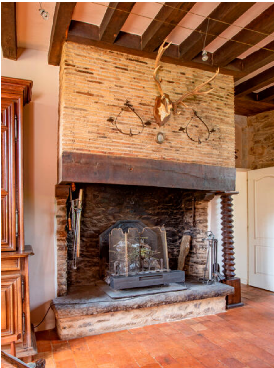
La cheminée de l'ancienne cuisine.
