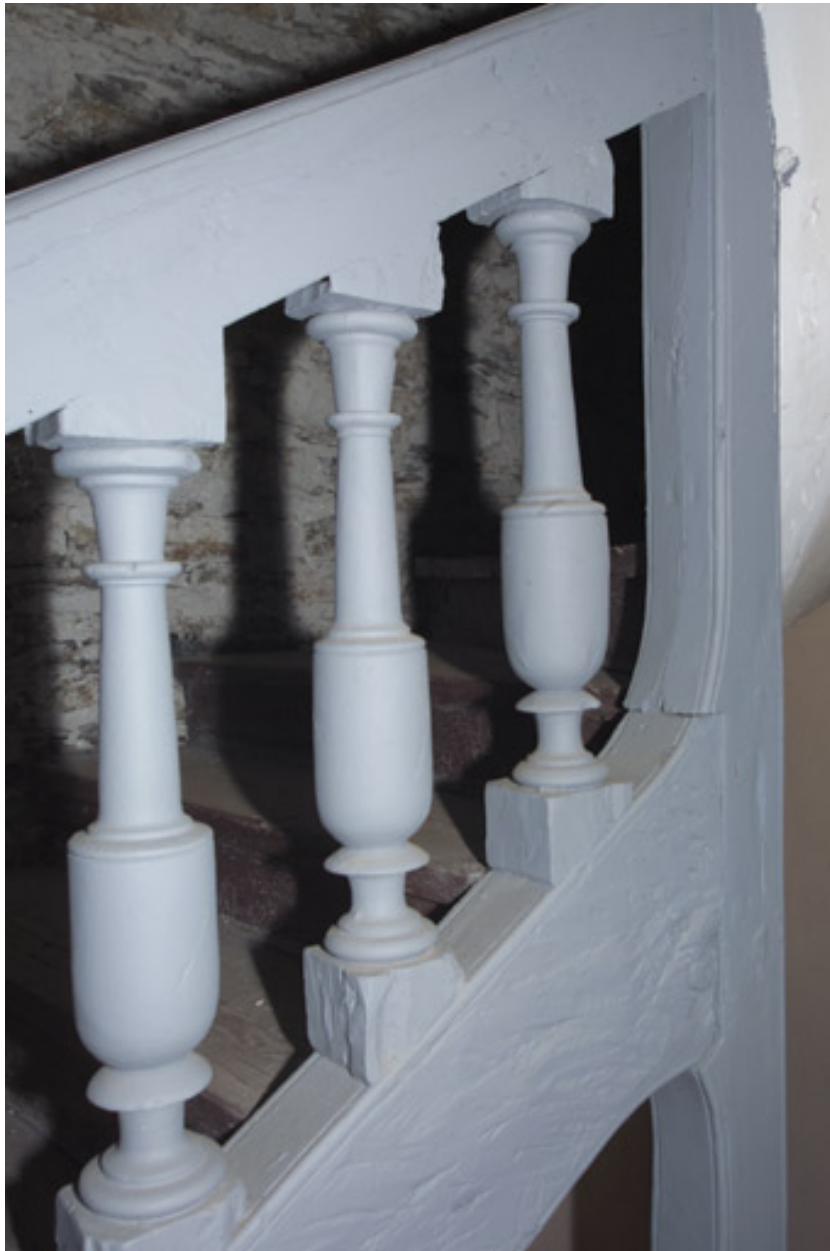
L'escalier, détail des balustres.
