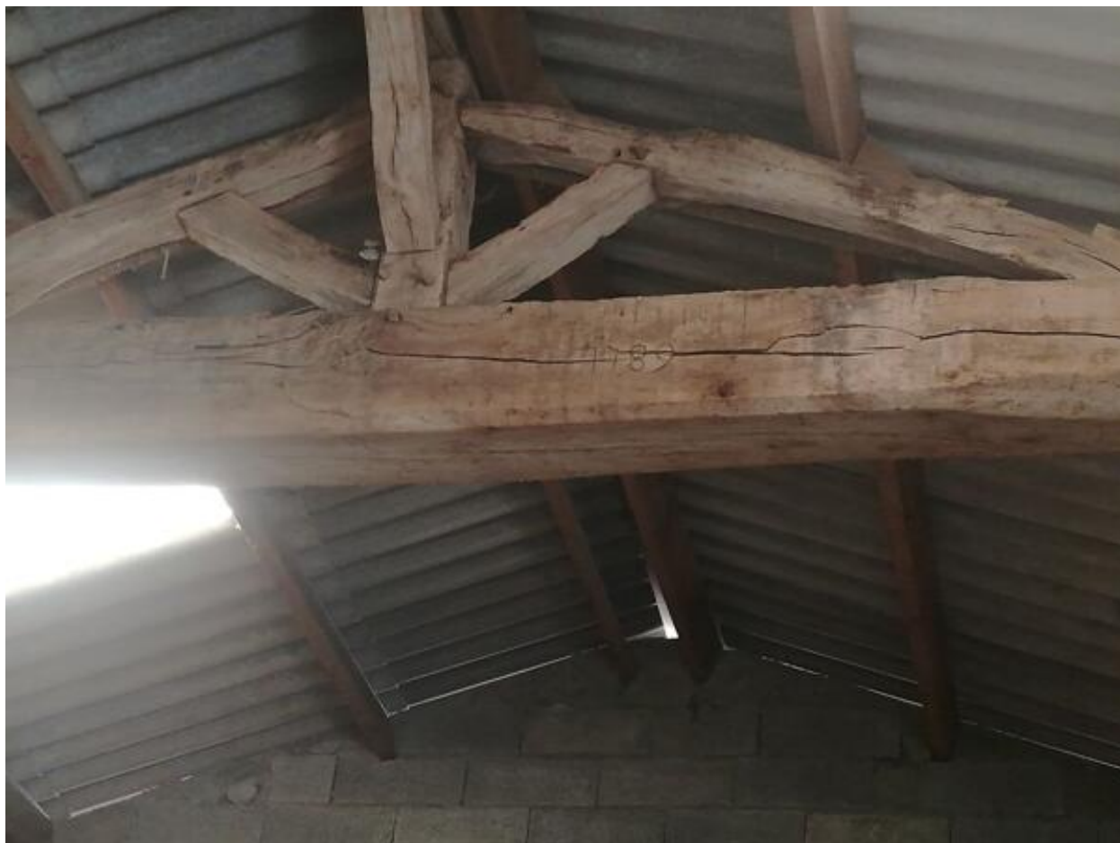
Saint-Germain. Détail de la date portée 1789 sur la charpente de la grange.
