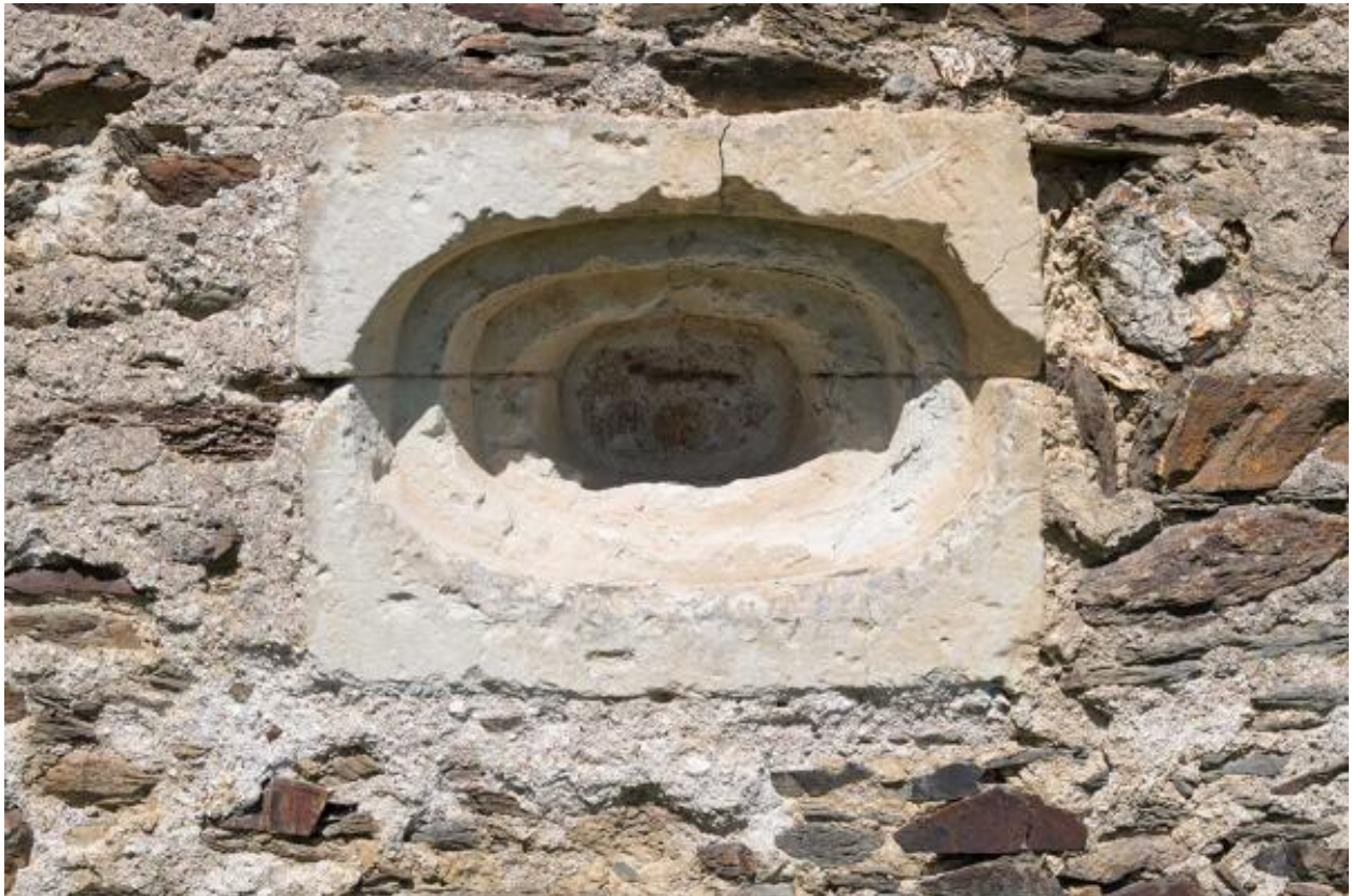
Détail d'une canonnière à redents sur le mur de clôture.
