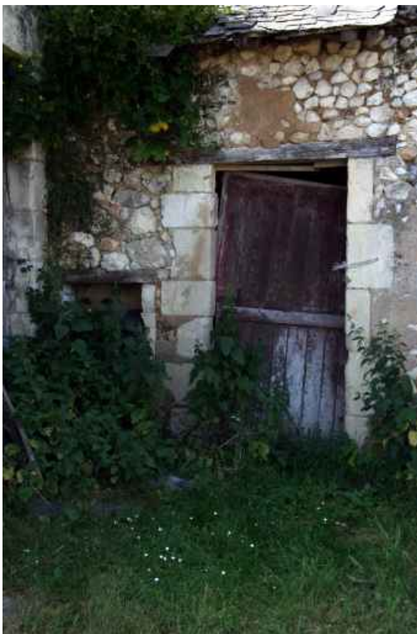
Porte de la buanderie aménagée dans les dépendances.
