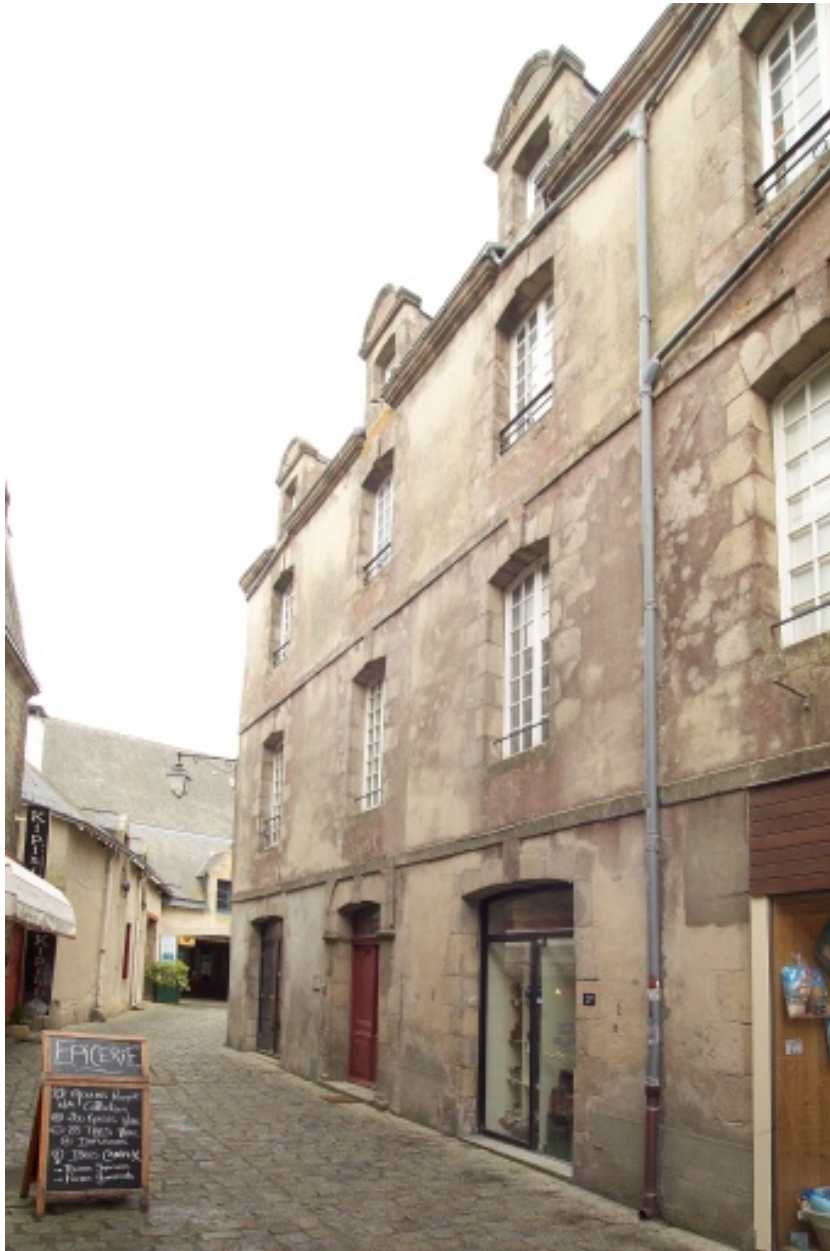
Vue du mur gouttereau bordant la rue de la Juiverie.
