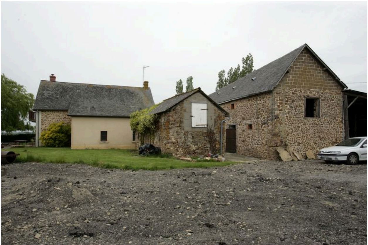
Vue d'ensemble depuis l'est : le logis, la porcherie, l'étable-grange.
