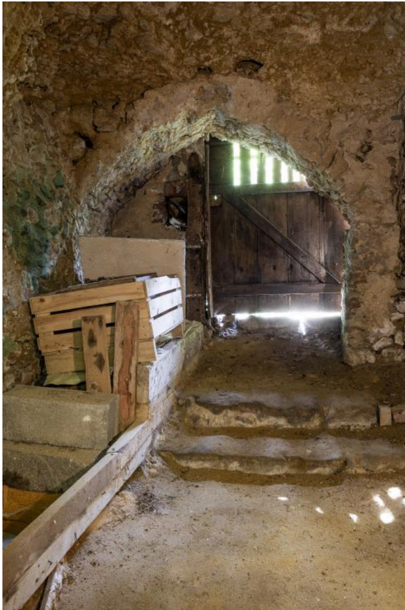
L'entrée du souterrain.
