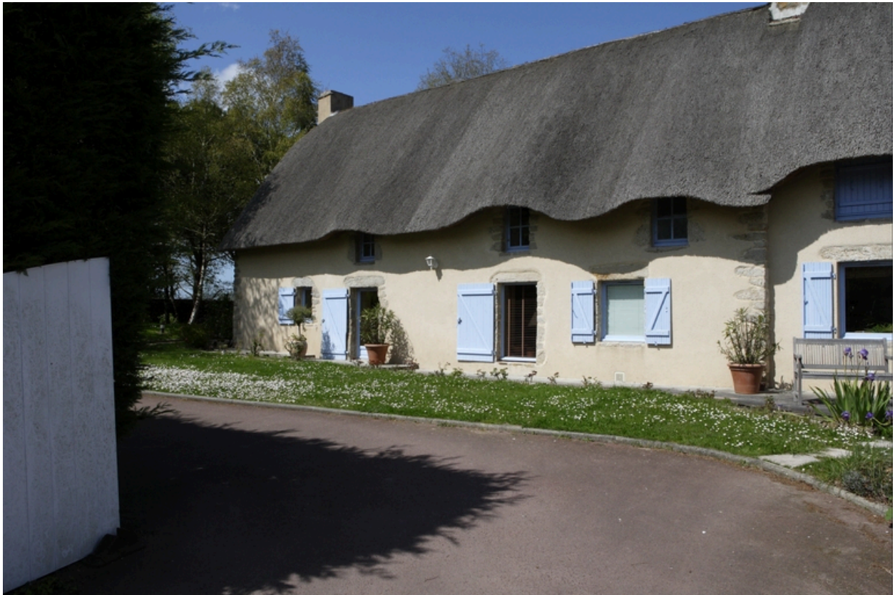
Vue depuis le sud-est.
