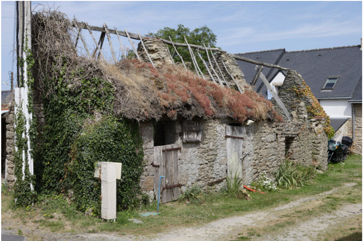
Vue de la porcherie du deuxième logis depuis le sud-est.
