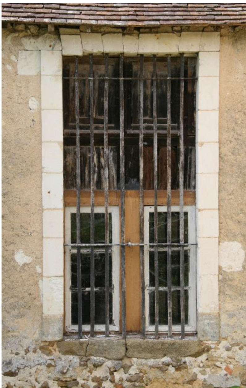
Les communs, aile est, façade postérieure : fenêtre.
