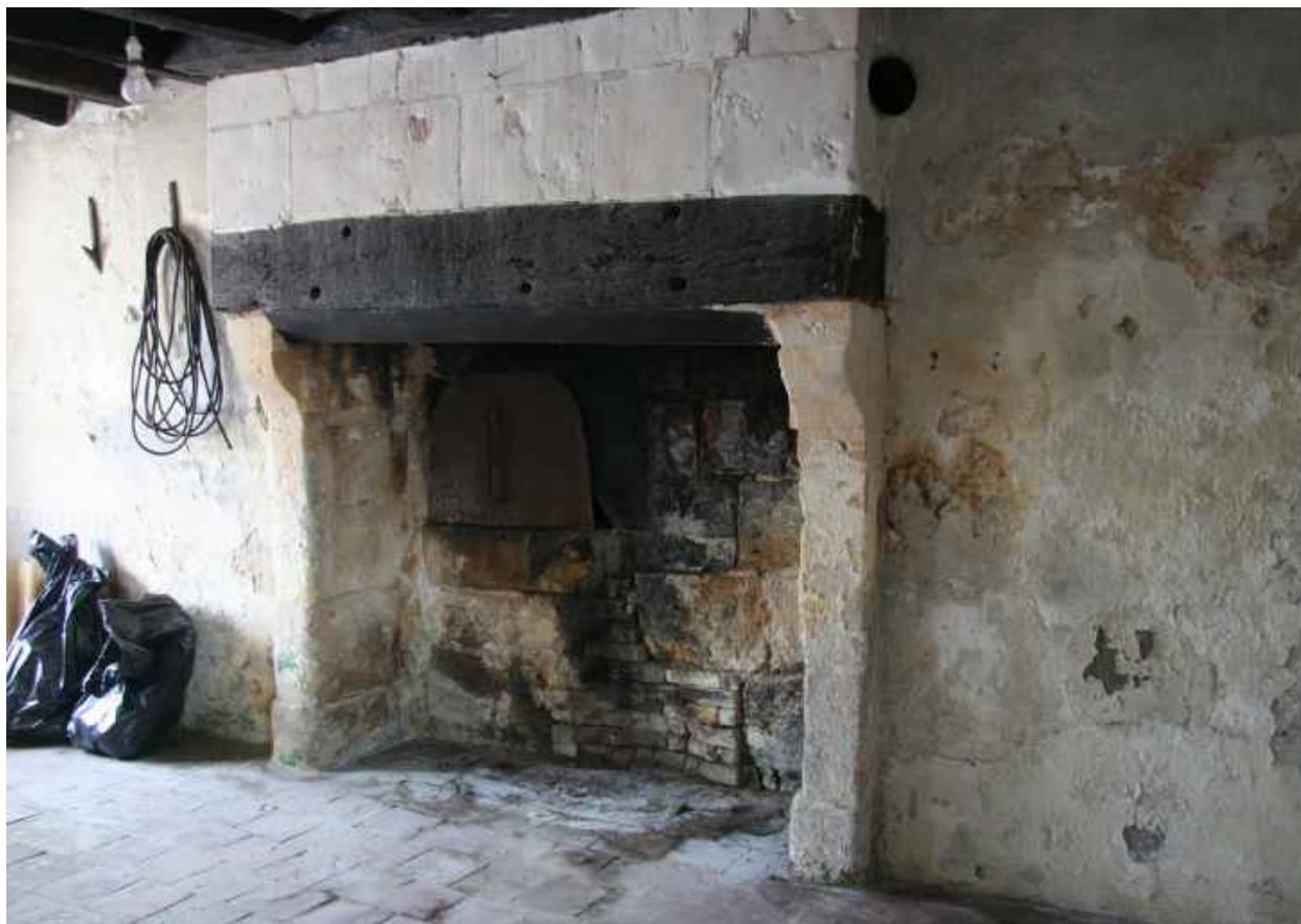
Cheminée de la chambre à feu.
