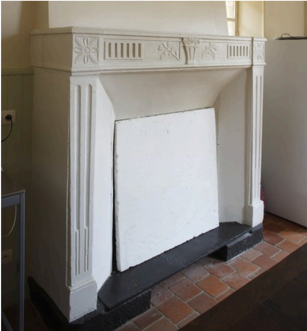
Cheminée de la cuisine.
