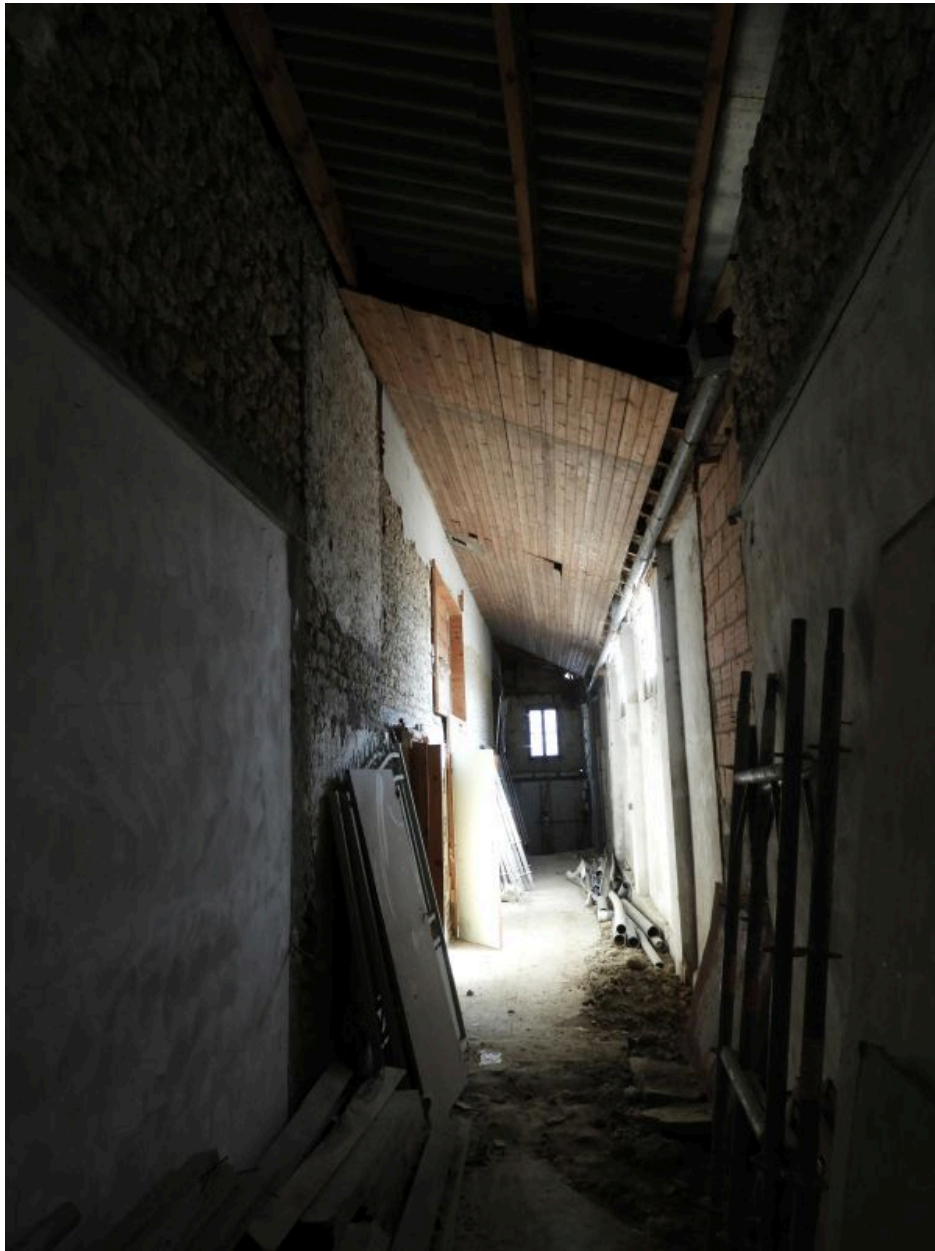
Le couloir parallèle à la salle de spectacle, vu en direction du nord.
