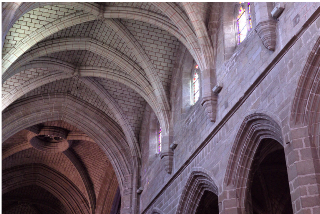
Voûtes du chœur.
