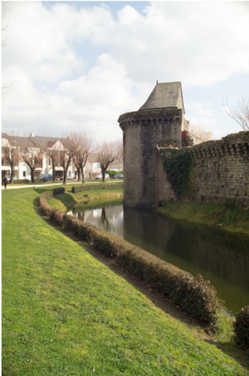
Vue générale vers l'Est.
