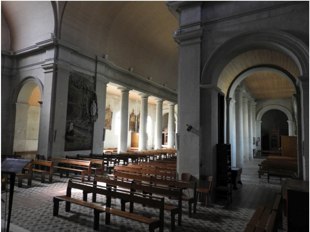
La nef et le bas-côté nord vus en direction du sud-ouest.
