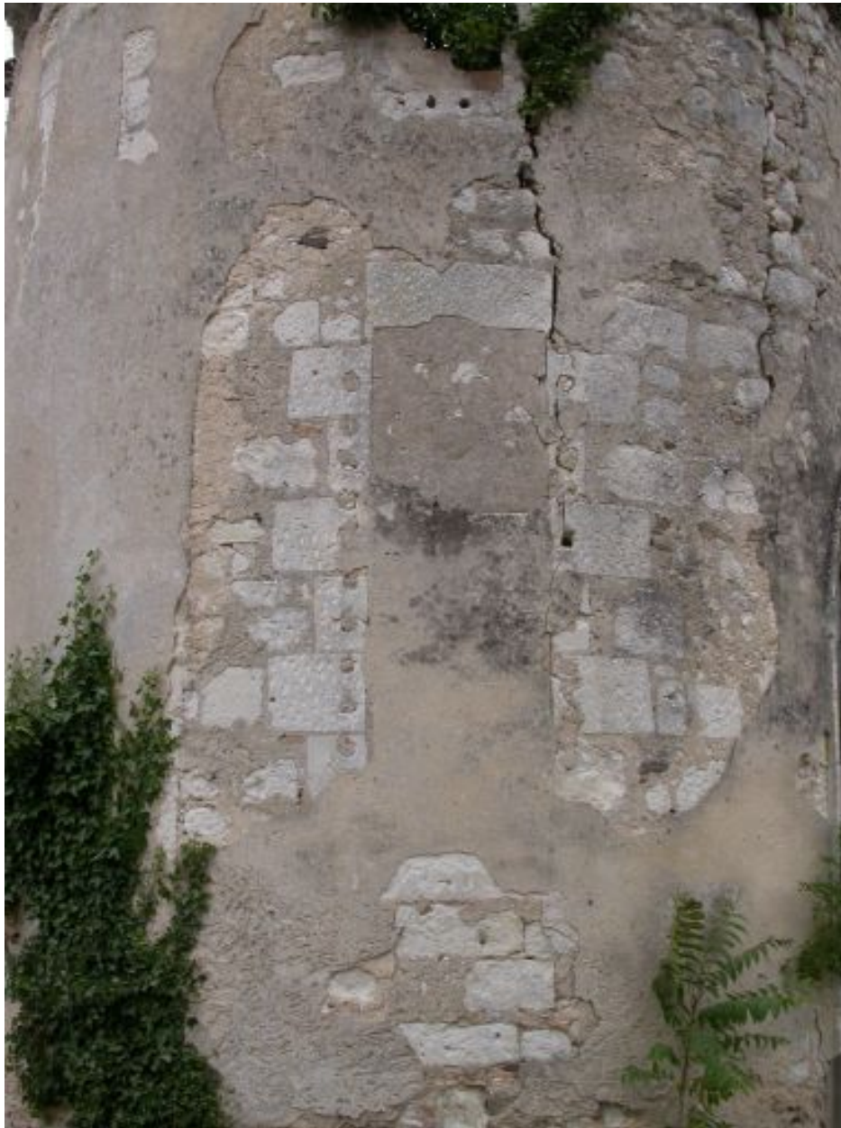
Tour d'angle de l'ancien château : ancienne baie.
